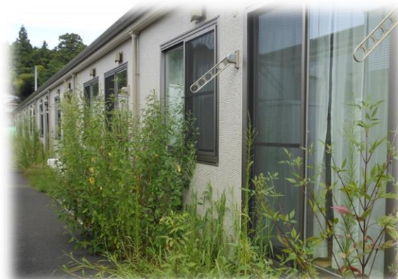
雑草が生い茂っている仮設住宅
